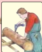
Navrtáme otvory. Navrtáme otvory.
